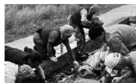
護岸ブロック植栽作業風景
